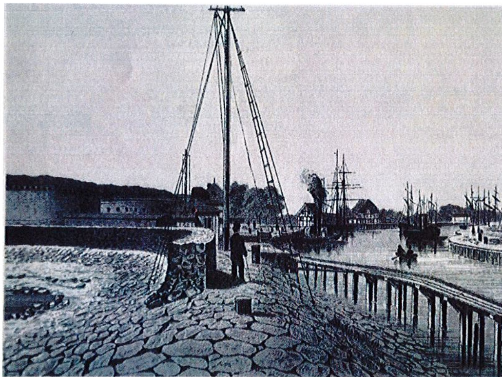
Il. 12. Widok fortu Ujście w latach 50 lub 60-tych XIX w. Na zdjęciu po lewej stronie widać półokrągłą baterie (na pierwszym planie) oraz bastiony z murowanymi przedpiesiami przeprutymi prostokątnymi otworami strzelniczymi (na drugim planie). Repr.: H. Kroczyński, Kronika Kołobrzegu . Kołobrzeg 2000 r.
