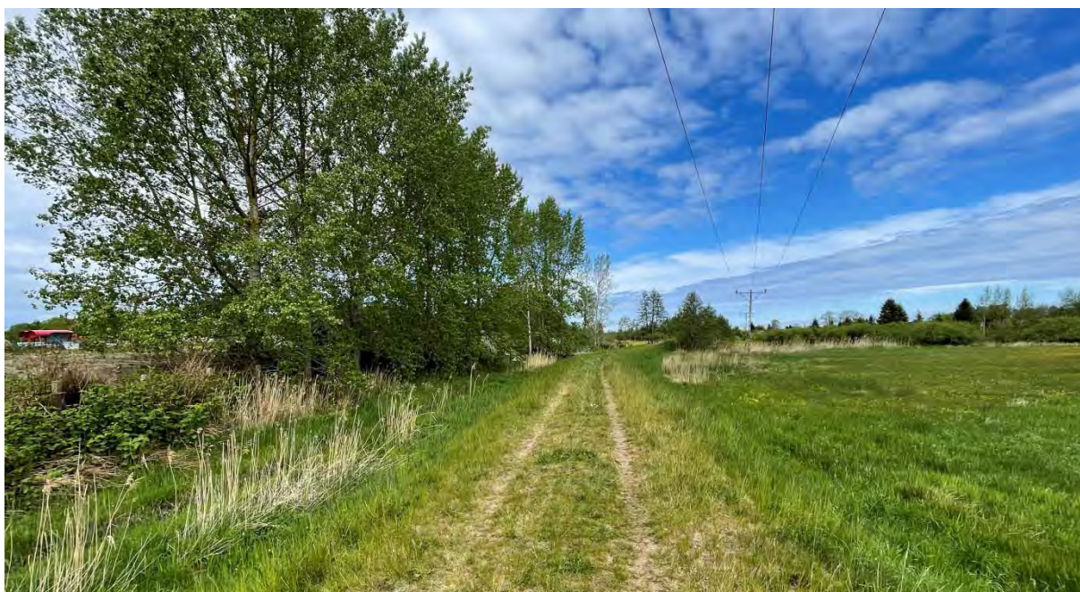
Rysunek 10 Wał przeciwpowodziowy – widok na północ (źródło: zdjęcia własne, maj 2022 r.)
