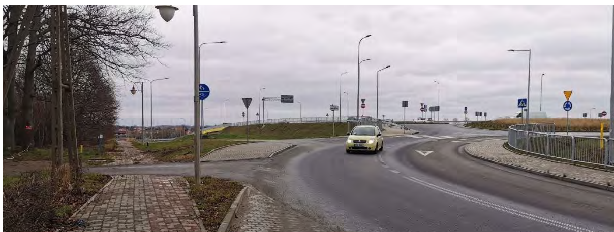
Rysunek 29 Rozjazd w sąsiedztwie nowo powstałej drogi ekspresowej S6, Źródło: autor: I. Szymańska, listopad 2020 r.
