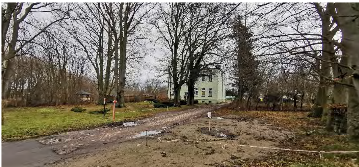
Rysunek 10 Na zdjęciu: budynek mieszkalny w otoczeniu drzew (widok od strony południowo-zachodniej), Źródło: autor: I. Szymańska, listopad 2020 r.
