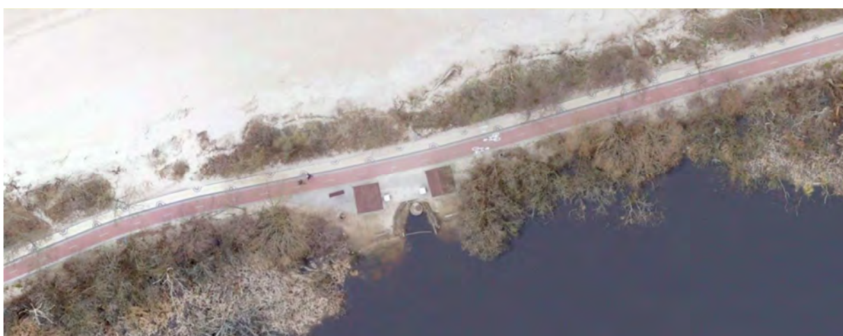
Altany i stojaki dla rowerów wzdłuż ścieżki rowerowej Źródło: ortofotomapa SIP UM Kołobrzeg
