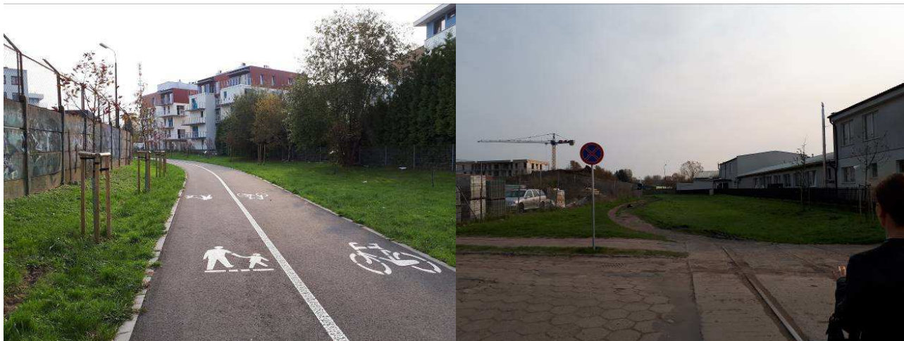
Zdjęcie 28 Ścieżka pieszo-rowerowa i miejsce planowanej jej kontynuacji. Źródło: UM Kołobrzeg
