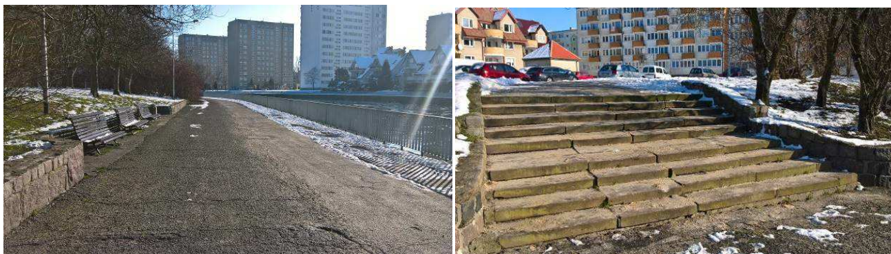
Zdjęcie 4 Bulwary nad rzeką Parsętą. Źródło: UM Kołobrzeg
