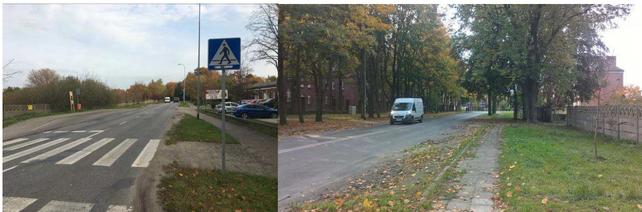
Zdjęcie 35 Droga ul. Mazowieckiej przed przebudową. Źródło: UM Kołobrzeg
