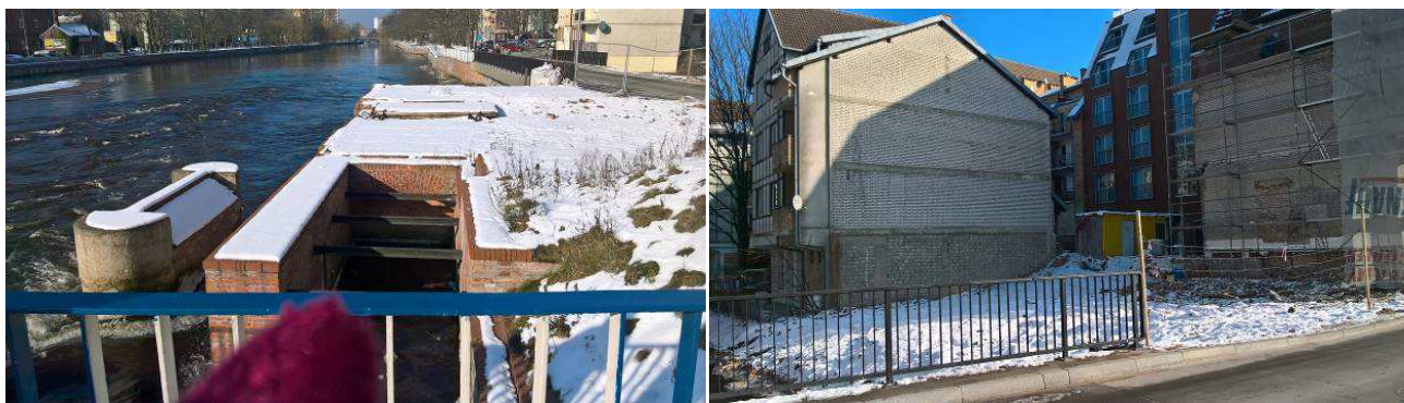
Zdjęcie 13 Rozebrany spichlerz i pozostałości po hydroforni Źródło: UM Kołobrzeg
