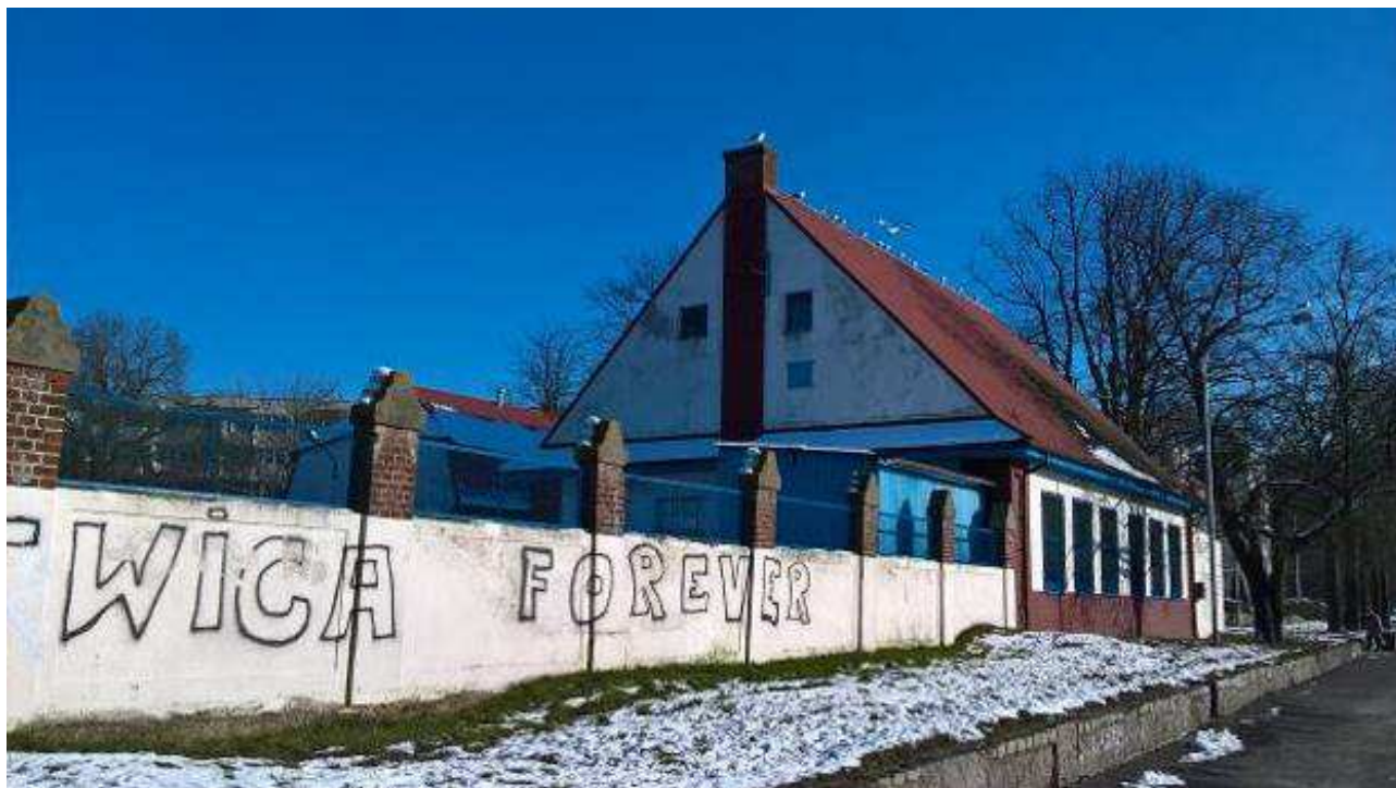
Zdjęcie 14 Przepompownia ścieków. Źródło: UM Kołobrzeg
