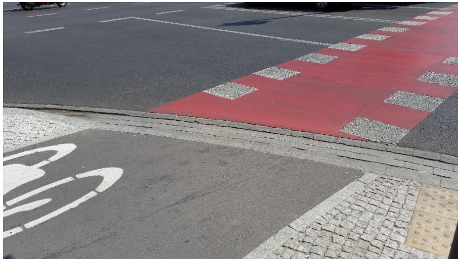
Fotografia 6.5 Przykład przejazdu rowerowego przez jezdnię z zastosowaniem minimalnych różnic terenu Źródło: materiały własne
