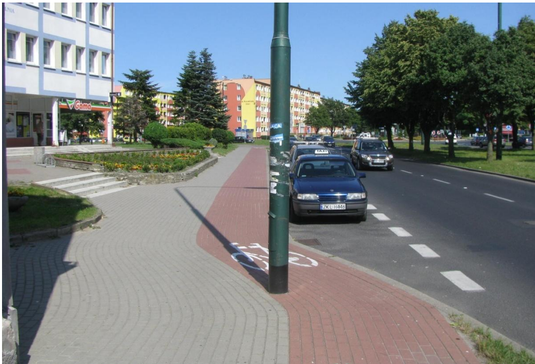
Fotografia 2.4 Niedopuszczalna z punktu widzenia bezpieczeństwa przeszkoda na drodze rowerowej źródło: zdjęcie własne
