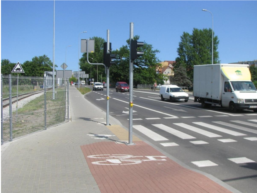
Fotografia 2.3 Wadliwe rozwiązanie geometryczne oraz zastosowanie przycisków wzбудzających zielony sygnał dla rowerzystów na ul. Solnej źródło: zdjęcie własne
