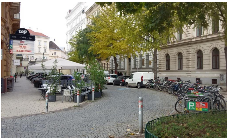
Fotografia 4.2 Przykład ulic z fizycznym uspokojeniem ruchu (wyniesione przejście i przewężenia) w Wiedniu Źródło: własne
