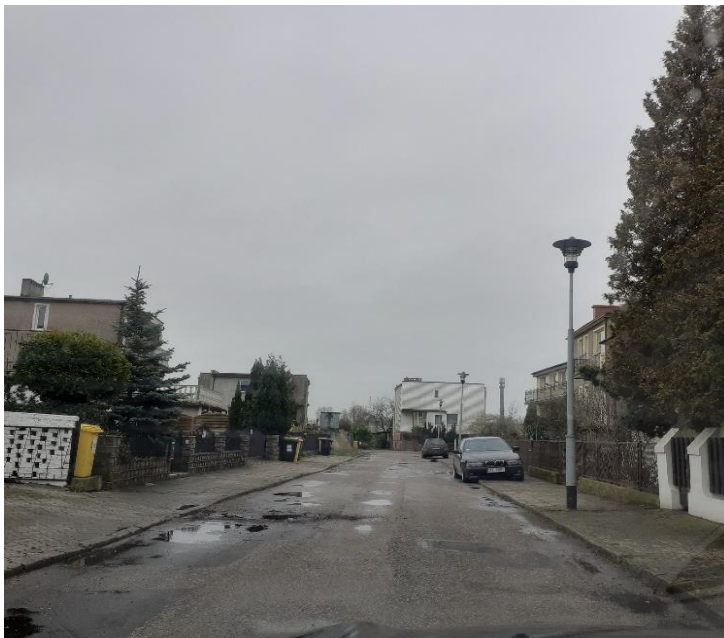
ul. Słoneczna przed przebudową (własne)
