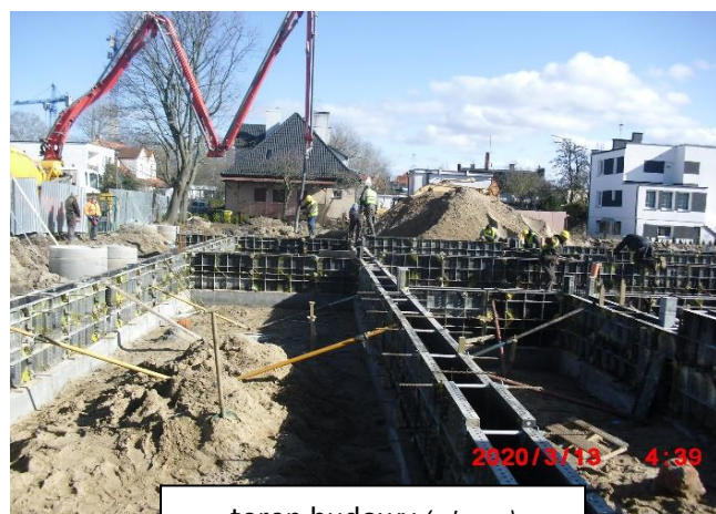
teren budowy (własne)
