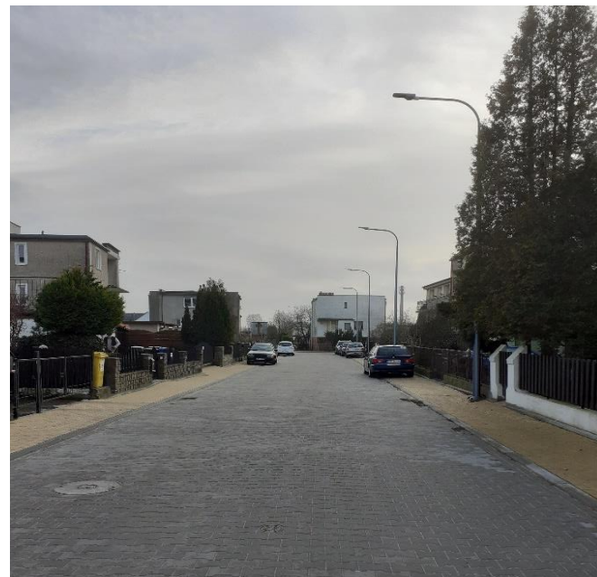
ul. Słoneczna po przebudowie (własne)
