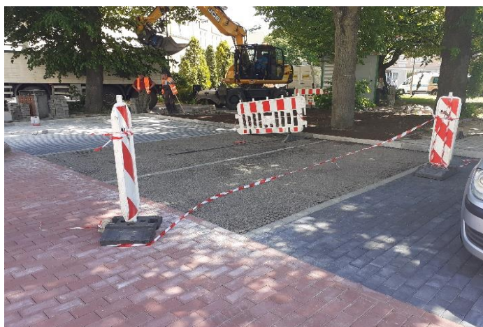
prace przy rozbudowie parkingu (własne)
