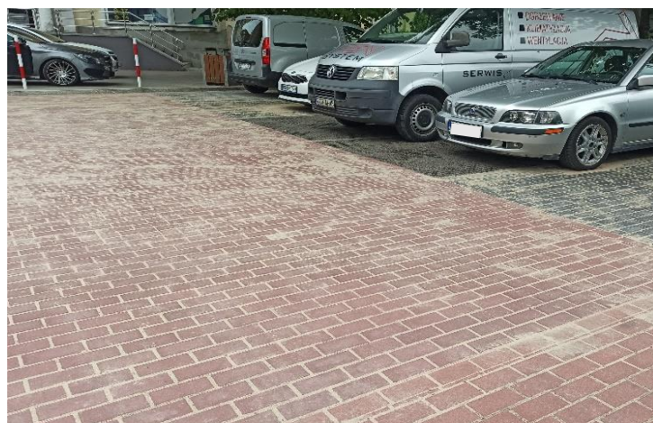
parking po przebudowie (własne)
