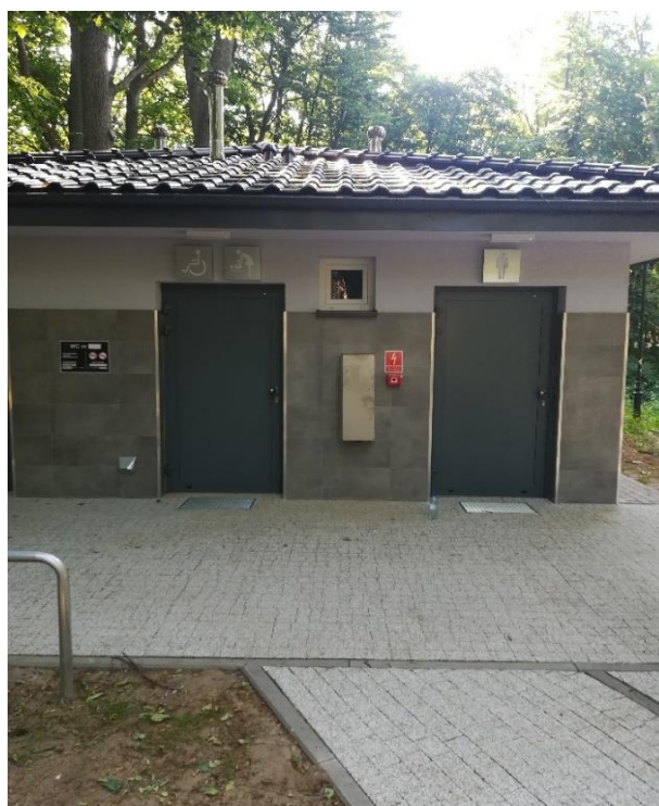
Toaleta po przebudowie (własne)
