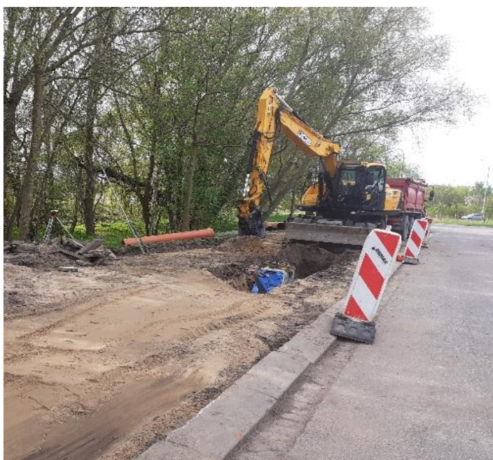
prace podczas budowy kanału (własne)
