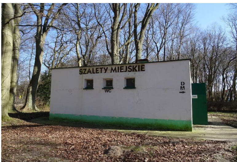
Toaleta przed przebudową (własne)
