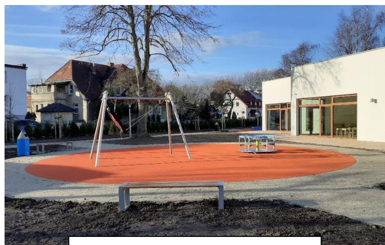
wybudowane przedszkole (własne)
