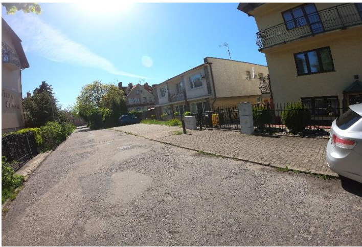
ul. Jaśminowa przed przebudową (własne)
