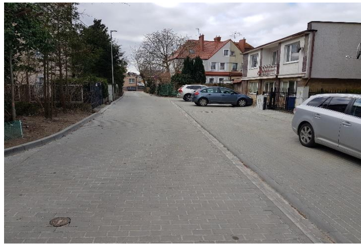
ul. Jaśminowa po przebudowie (własne)
