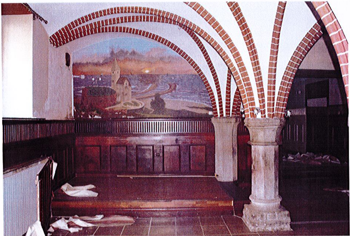
Fot.14. Kołobrzeg, Ratusz, Restauracja Adabar, główna sala restauracji stan z 2017r.
