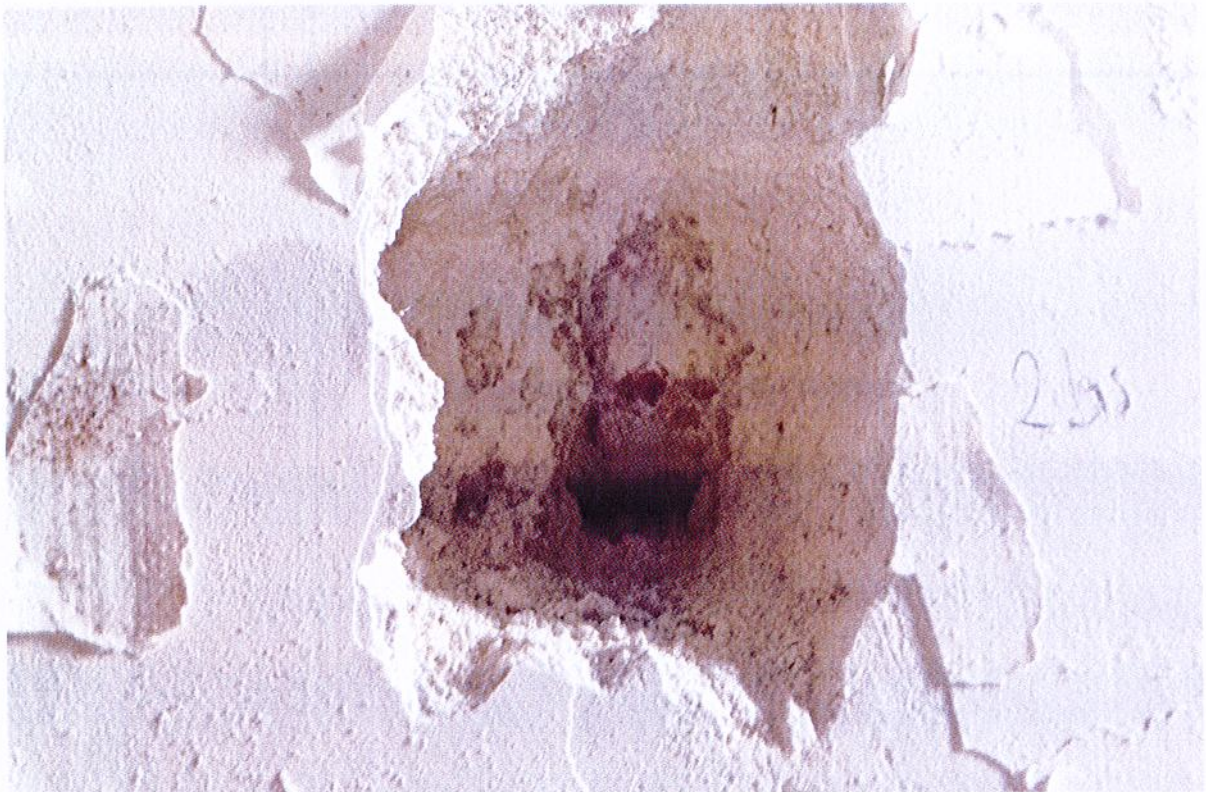
Fot.35. Kołobrzeg, Ratusz, Restauracja Adabar, główna sala restauracji. Odkrytki sondażowe tynków – ściana zachodnia Sali głównej, strona północna. Sporadycznie, pod bardzo grubą warstwą materiałów wtórnych odnaleźć można fragmenty wypraw historycznych.
