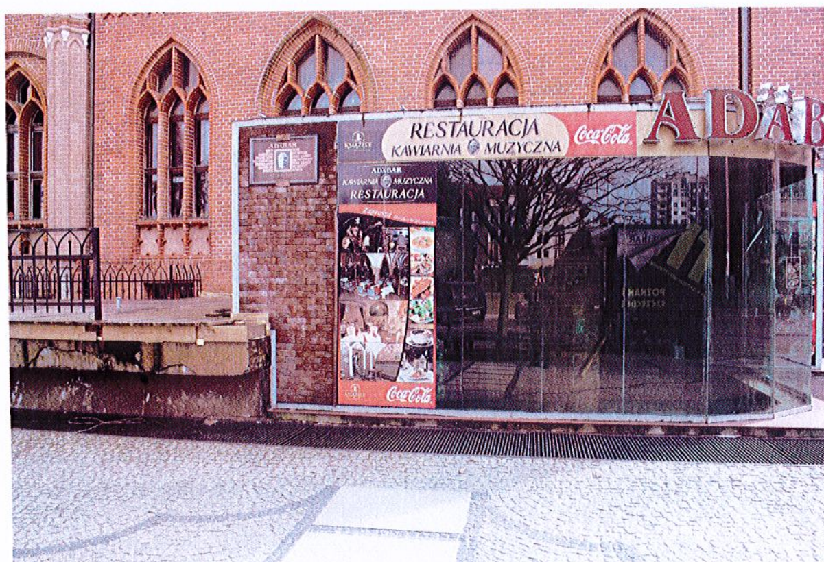
Fot.2. Kołobrzeg, Ratusz, Restauracja Adabar, główna klatka schodowa restauracji, 2017r.
