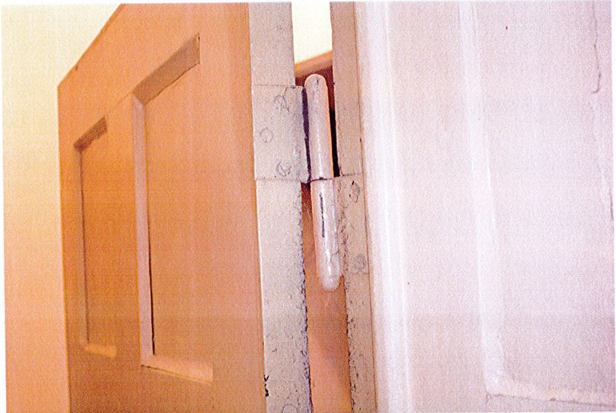
Fot.50. Kołobrzeg, Ratusz, Restauracja Adabar, sala różana. Drzwi ramowo-płycinowe. Na zdjęciu ewidentnie XX wieczny zawias czopowy.
