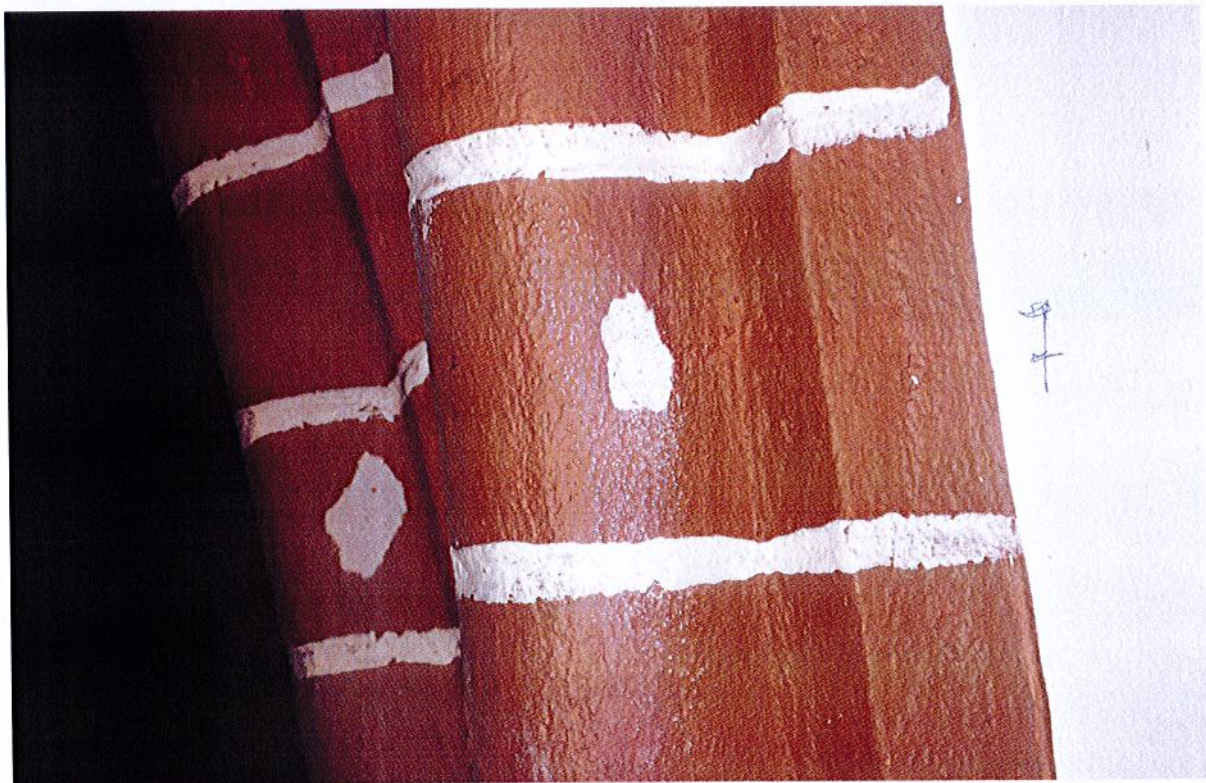
Fot.30. Kołobrzeg, Ratusz, Restauracja Adabar, główna sala restauracji. Odkrywki sondażowe żeber nad kolumną z I fazy chronologicznej. Obecne na sklepieniach żebrowanie jest w większości wykonaną w narzucie rekonstrukcją.
