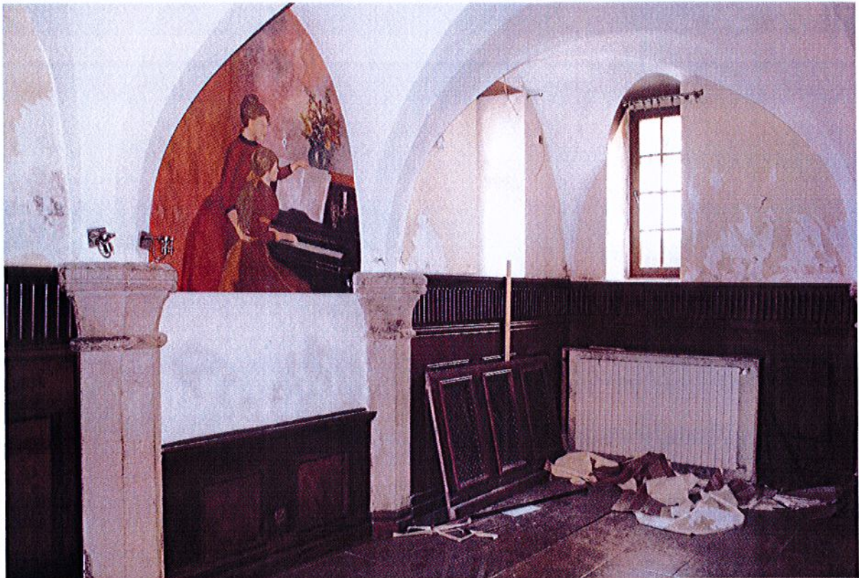
Fot.15. Kołobrzeg, Ratusz, Restauracja Adabar, główna sala restauracji stan z 2017r.
