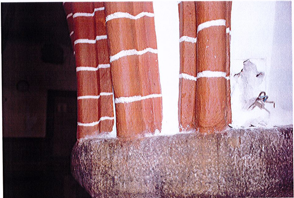
Fot.28. Kołobrzeg, Ratusz, Restauracja Adabar, główna sala restauracji. Obecne na sklepieniach żebrowanie jest w większości wykonaną w narzucie rekonstrukcją.
