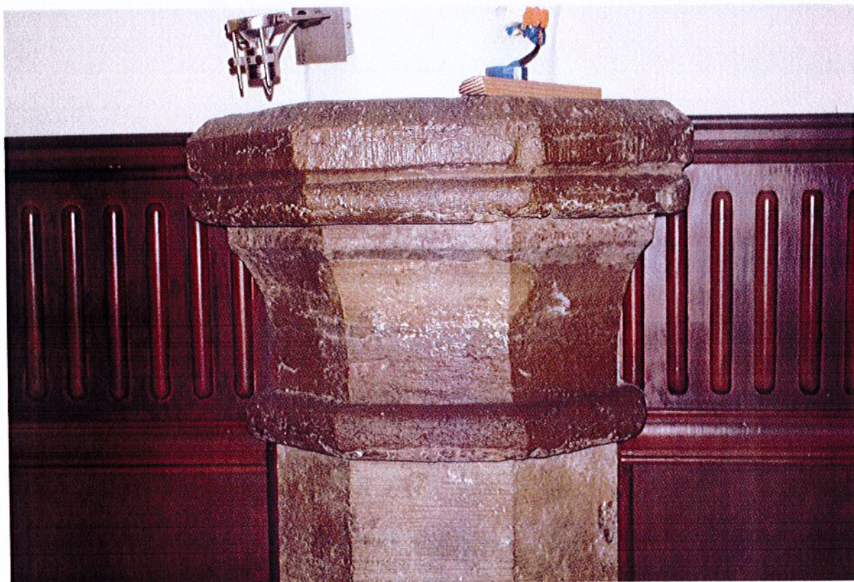
Fot.26. Kołobrzeg, Ratusz, Restauracja Adabar, główna sala restauracji. Półkolumna z wapienia zbitego, z III fazy chronologicznej. Powierzchnia kamienia jest silnie zatuszczona, najprawdopodobniej pokryta „domowymi” preparatami do pielęgnacji kamienia.
