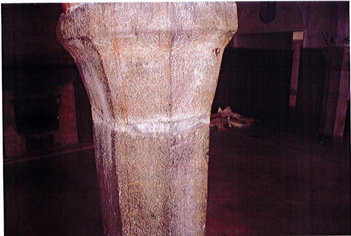
Fot.22. Kołobrzeg, Ratusz, Restauracja Adabar, główna sala restauracji. Kolumna granitowa z I fazy chronologicznej. Pęknięcie, lub zamierzony podział pomiędzy bryłami kolumny wypełniono zaprawą mineralną. Na zdjęciu widoczna także deformacja geometrii spowodowana przesunięciem elementów. Granit jest wyraźnie zabrudzony i zatłuszczony.
