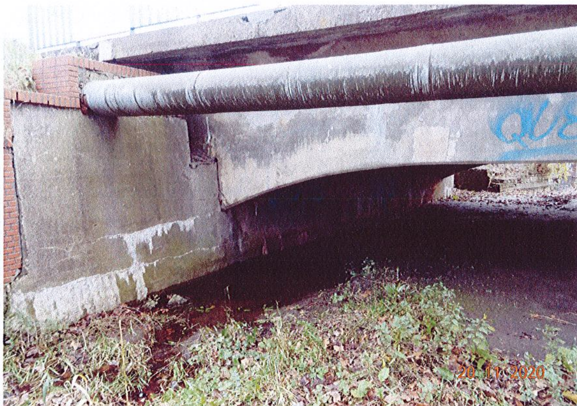
Fot. 9. Widok lewego przyczółka mostu od strony rzeki Parsęty.
