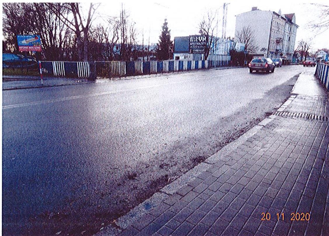
Fot. 4. Widok prawej części nawierzchni mostu od strony ul. Kamiennej.
