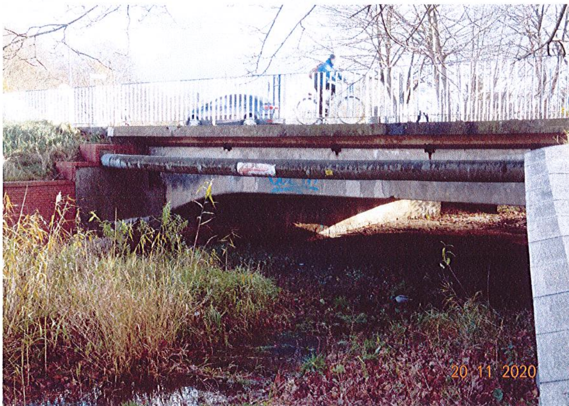
Fot. 1. Widok mostu od strony rzeki Parsęty.
