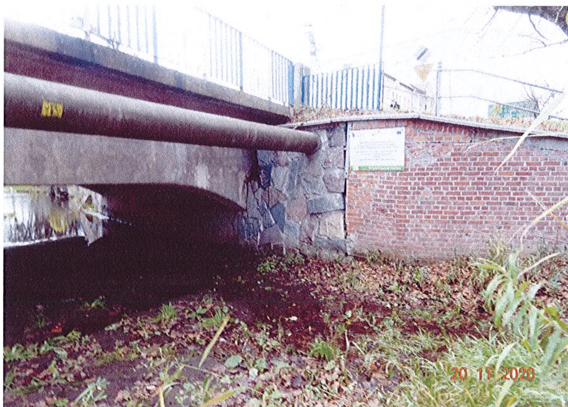
Fot. 8. Widok prawego przyczółka mostu od strony rzeki Parsęty.
