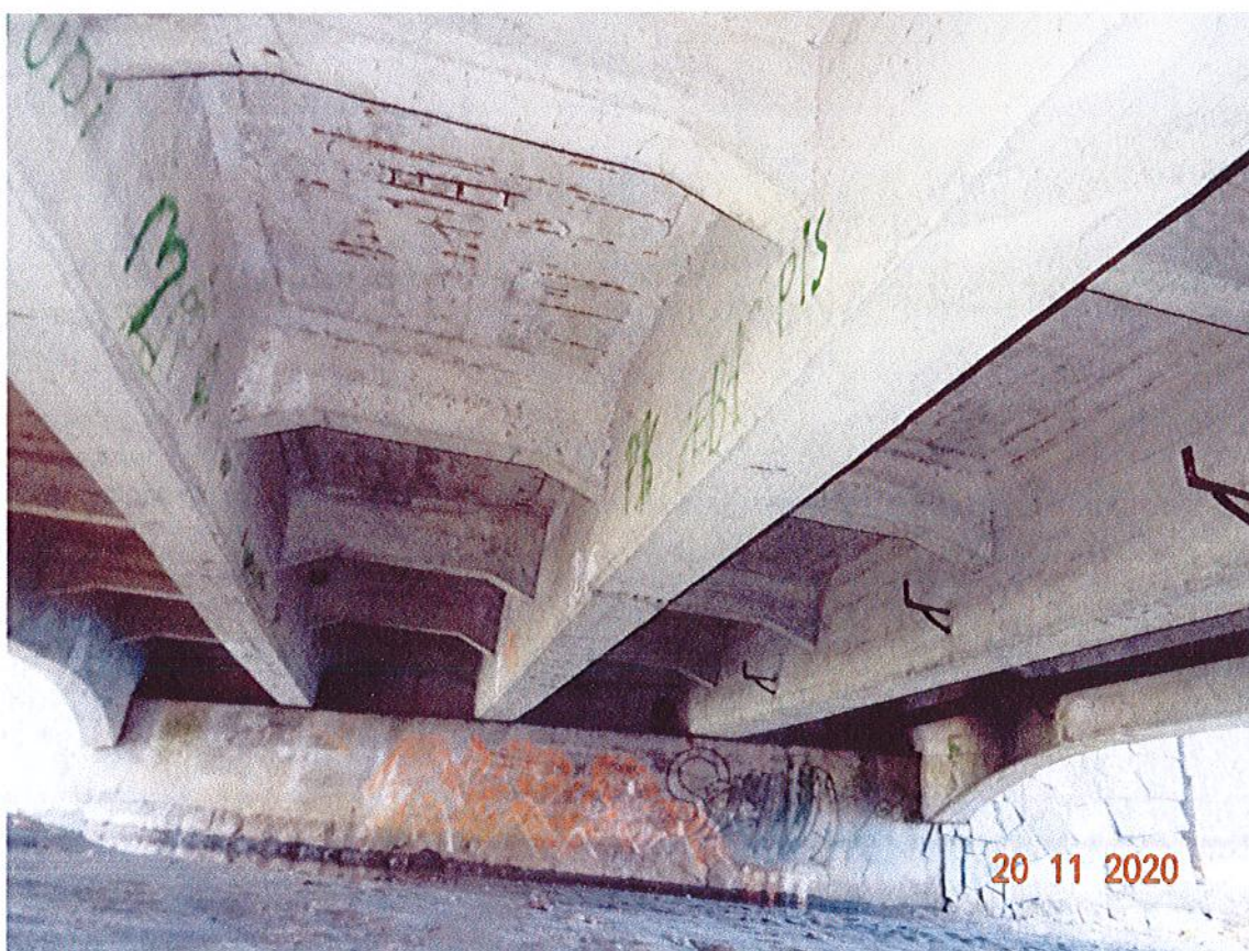
Fot. 10. Widok obiektu od spodu.
