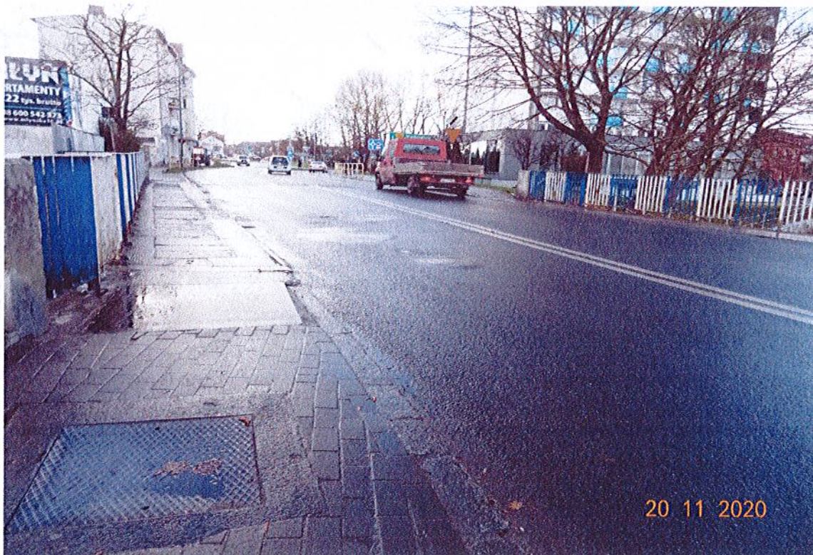
Fot. 3. Widok lewej części nawierzchni mostu od strony ul. Kamiennej.
