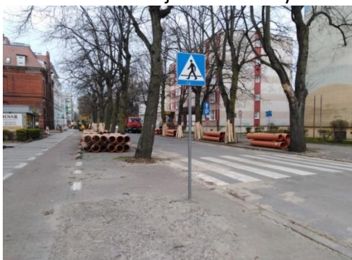
ul. Zwycięzców przed przebudową (własne)
