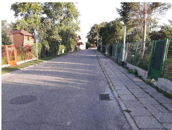
ul. Basztowa przed przebudową (własne)
