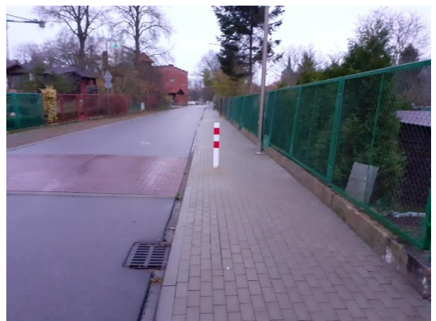
ul. Basztowa po przebudowie (własne)
