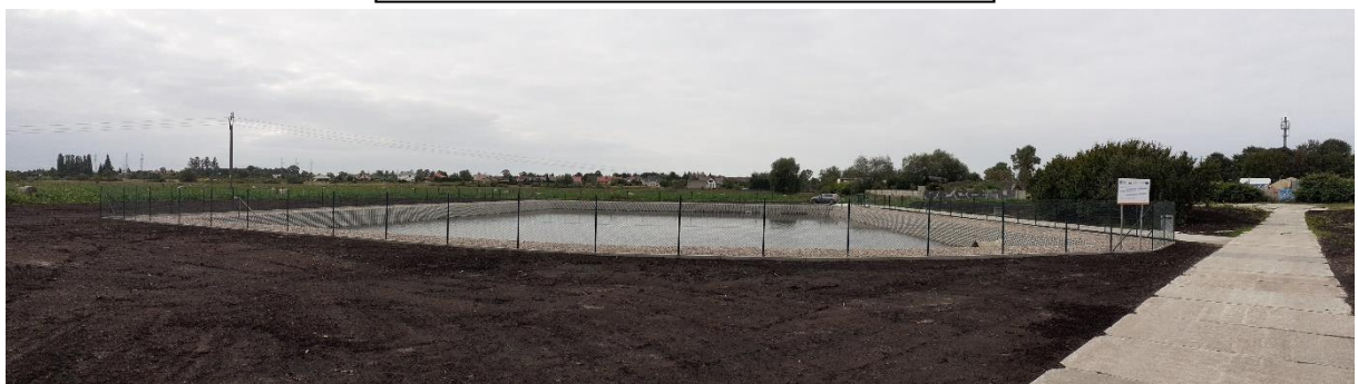
nowo wybudowany zbiornik (własne)
