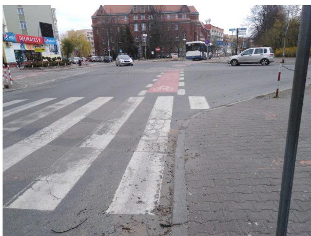
ul. 18 Marca przed przebudową (własne)
