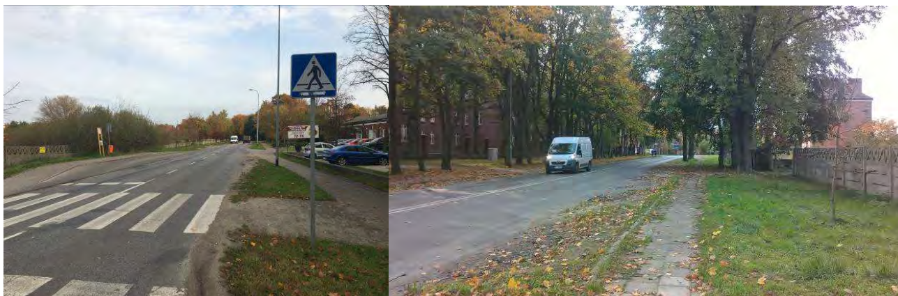
Zdjęcie 35 Ulica Mazowiecka przed przebudową. Źródło: UM Kołobrzeg
