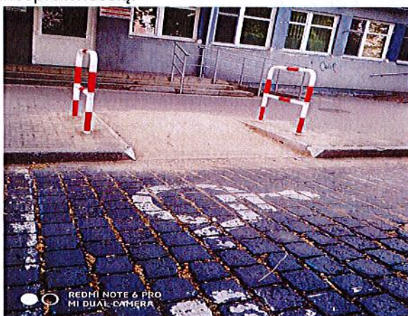
ul. Kolejowa - obniżenie krawężnika przy miejscu do parkowania dla osób niepełnosprawnych
