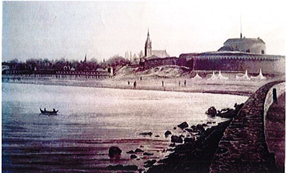
Il. 14. Pocztówka pokazująca fragment wybrzeża w okresie pomiędzy 1876 a 1892 lub 1894. Na zdjęciu widać fort po modernizacji ukończonej ok. 1876 roku. Rozebrano taras artyleryjski a sklepienie przykryto ziemią. W 1887 roku obiekt zdemilitaryzowano, a w latach 1892-1894 prawdopodobnie splantowano forty i rozebrano przedpiersia.
