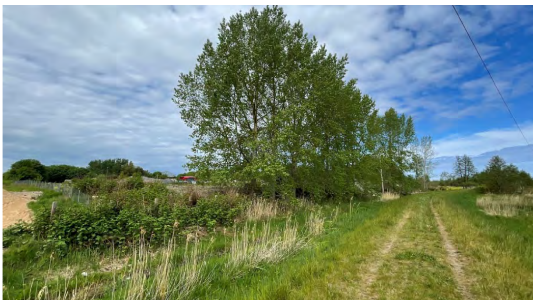
Rysunek 6 Wał przeciwpowodziowy i rów melioracyjny – pld.-wsch. narożnik terenu opracowania (źródło: zdjęcia własne, maj 2022)
