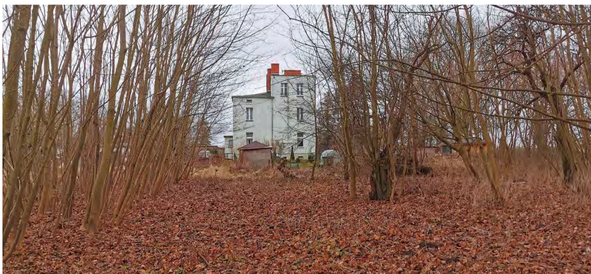
Rysunek 11 Na zdjęciu: budynek mieszkalny w otoczeniu drzew (widok od strony północnej), Źródło: autor: I. Szymańska, listopad 2020 r.
