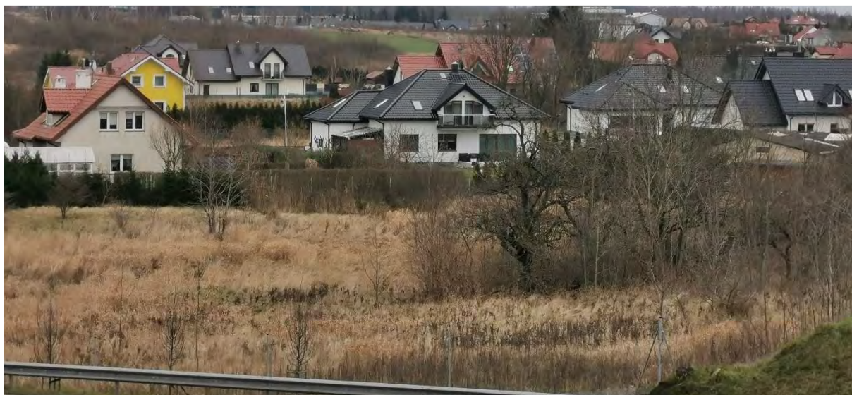
Rysunek 14 Na zdjęciu: roślinność wokół budowli odwadniających skrzyżowanie przy drodze ekspresowej – przystryżone trawy na skarpach, drożne rowy odwadniające, Źródło: autor: I. Szymańska, listopad 2020 r.
