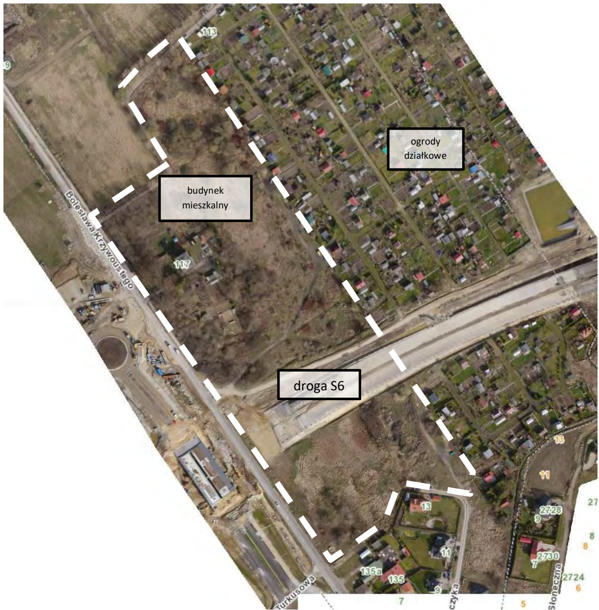
Rysunek 8 Obszar opracowania – budynek mieszkalny, droga ekspresowa oraz tereny niezabudowane, Źródło: ortofotomapa z SIP UM Kołobrzeg
