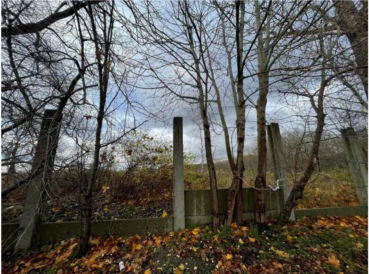
Rysunek 10 Największe skupisko drzewostanu zlokalizowane jest wzdłuż ogrodzenia przy ul. Pińskiej – na zdjęciu fragment betonowego ogrodzenia terenów powojkowych
