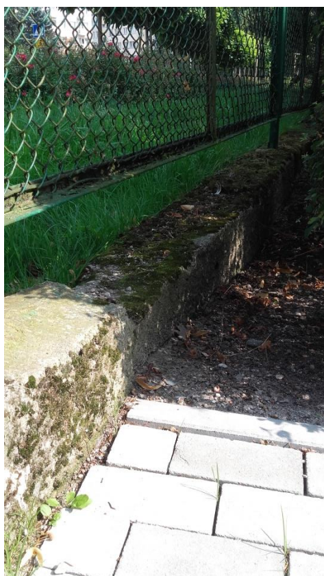
Istniejące ogrodzenie na cokole betonowym
