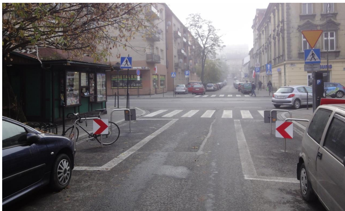
Zdjęcie 6.3 Przykład montażu stojaków rowerowych przed przejściami dla pieszych w Krakowie źródło: www.viavistula.pl
