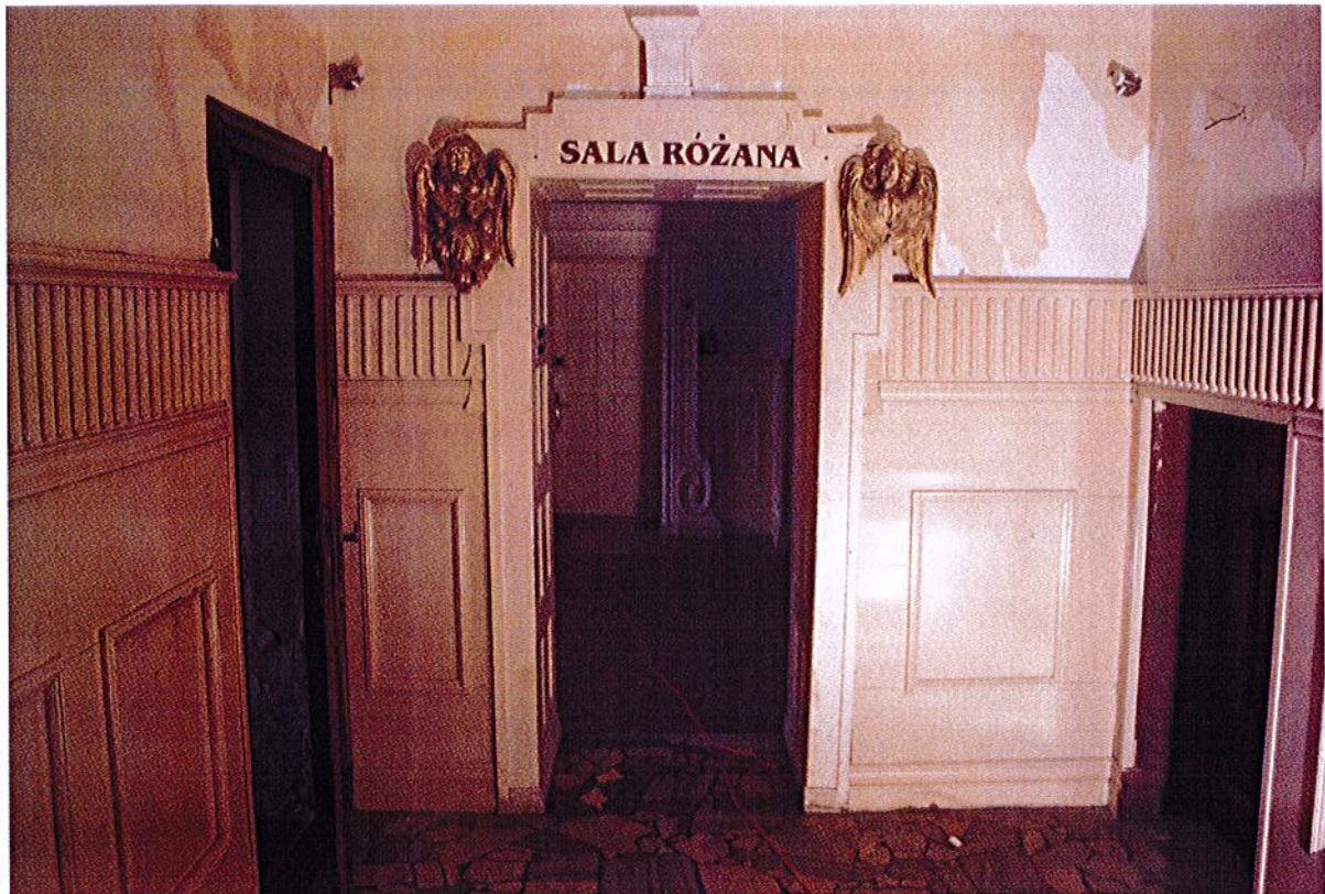
Fot.47. Kołobrzeg, Ratusz, Restauracja Adabar, sala różana. Awers ościeżnicy bez skrzydła. Pomimo silnej brutalizacji historyczna stolarka zachowała się w dość dobrym stanie.
