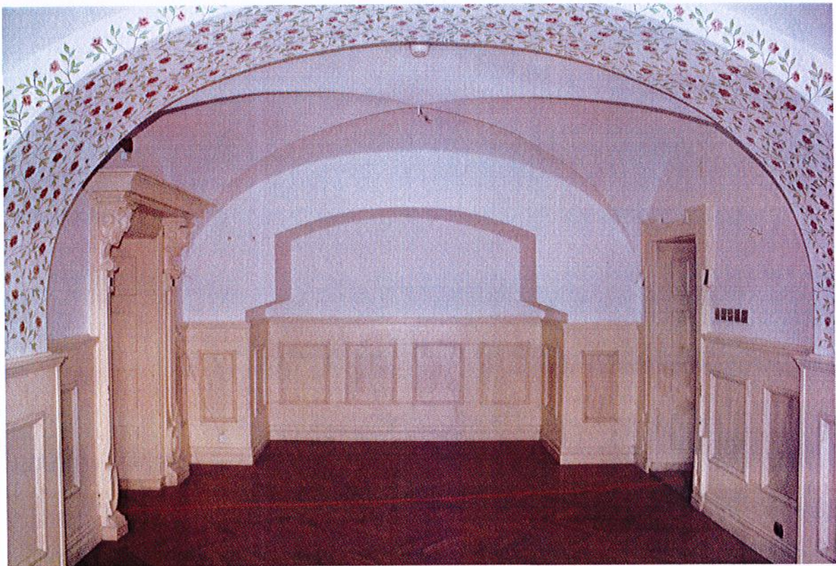
Fot.44. Kołobrzeg, Ratusz, Restauracja Adabar, sala różana, 2017r. W pomieszczeniu tym zachowały się dwie historyzujące ościeżiny pochodzące zapewne z okresu adaptacji – początek XX wieku. Na podłodze widoczny jest także parkiet z dębowej klepki ułożonej w jodełkę.
