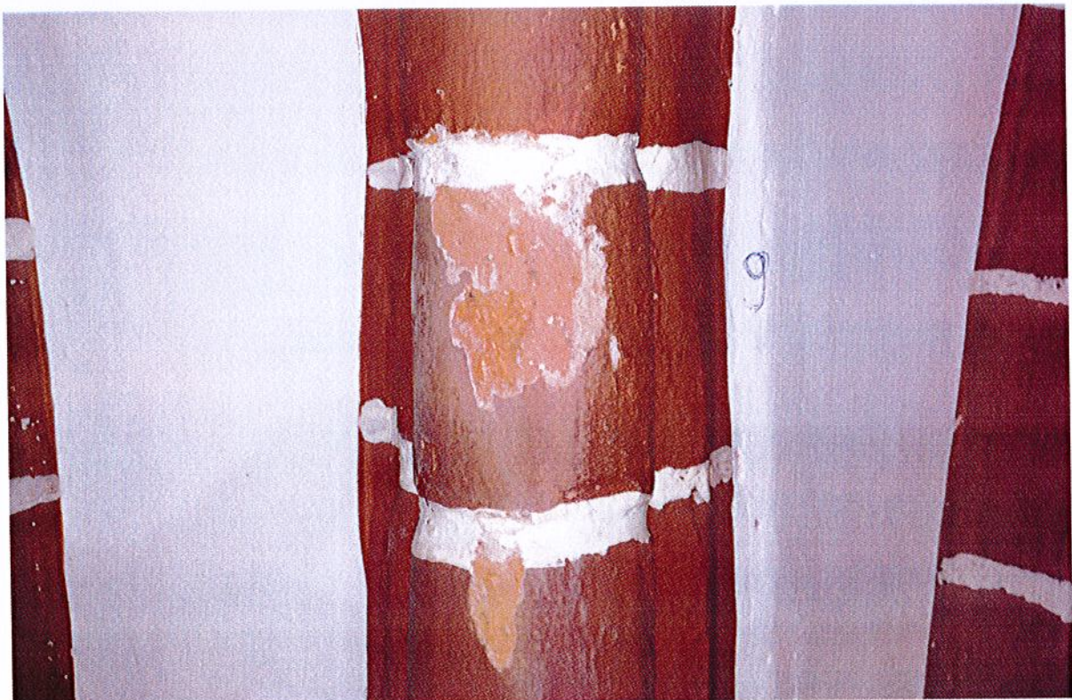
Fot.32. Kołobrzeg, Ratusz, Restauracja Adabar, główna sala restauracji. Odkrywki sondażowe żeber nad kolumną z III fazy chronologicznej. Obecne na sklepieniach żebrowanie jest w większości wykonaną w narzucie rekonstrukcją, elementy ceramiczne obecne są sporadycznie.
