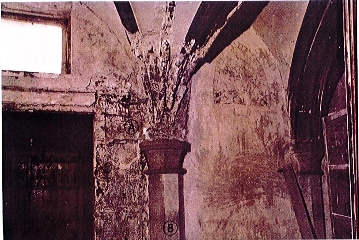
Fot.29. Kołobrzeg, Ratusz, Restauracja Adabar, główna sala restauracji. Obecne na sklepieniach żebrowanie jest w większości wykonaną w narzucie rekonstrukcją. Stan zachowania żebrowania dokumentują odkrywki wykonane przez PKZ w 1974r.
