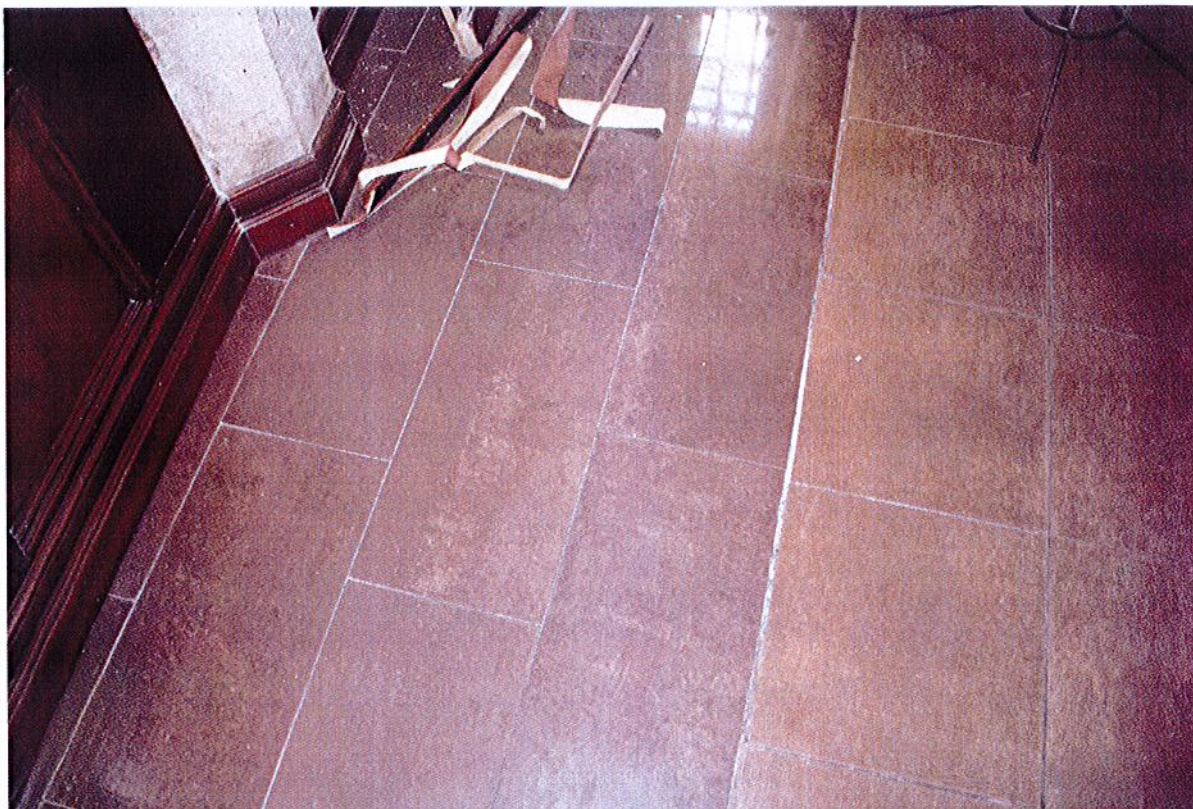
Fot.19. Kołobrzeg, Ratusz, Restauracja Adabar, główna sala restauracji. Posadzkę Sali restauracyjnej wykonano z kilku materiałów. Na zdjęciu płytki z kamienia naturalnego (?) oraz typowa płytką gresowa.
