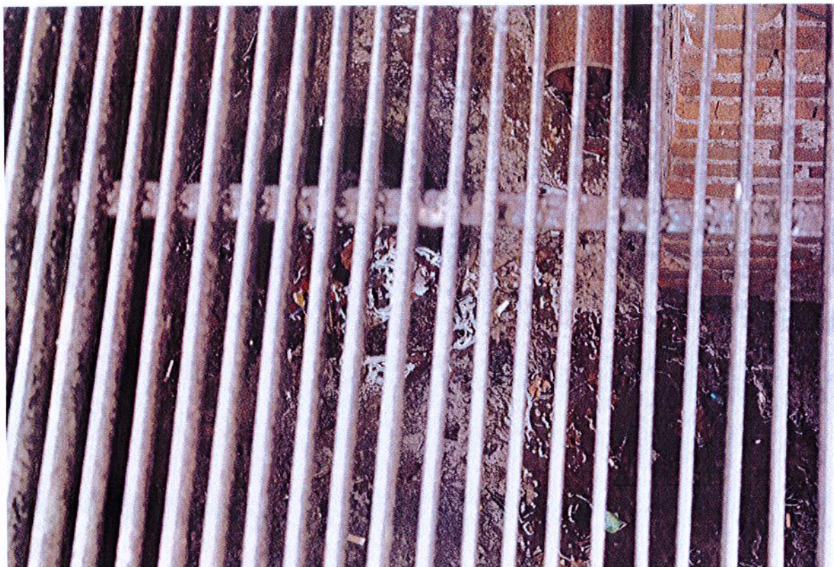
Fot.5. Kołobrzeg, Ratusz, Restauracja Adabar, wewnątrz fosy, dno i rury drenażowe fosy, nawet po niewielkich opadach wypełnione są przez długi czas wodą.
