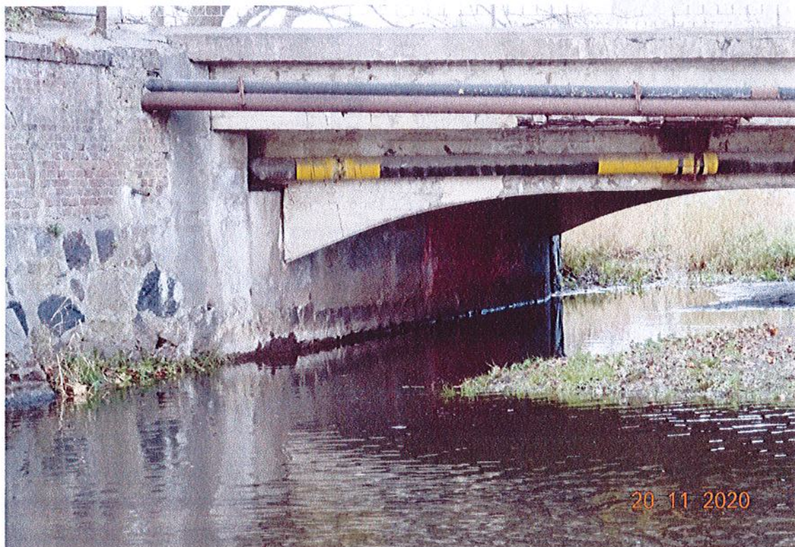
Fot. 6. Widok lewego przyczółka mostu od strony Kanału Drzewnego.
