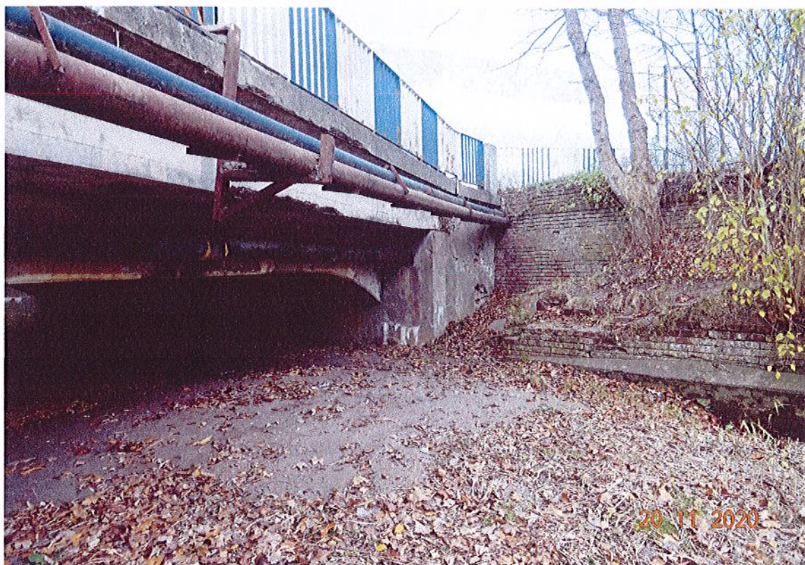
Fot. 7. Widok prawego przyczółka mostu od strony Kanału Drzewnego.
