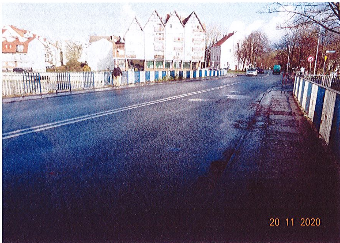
Fot. 5. Widok nawierzchni mostu od strony ul. Szpitalnej.
