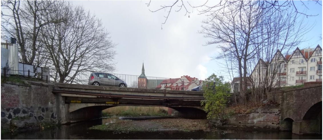
fol. 3 - Widok od strony Kanału Drzewnego Małego
