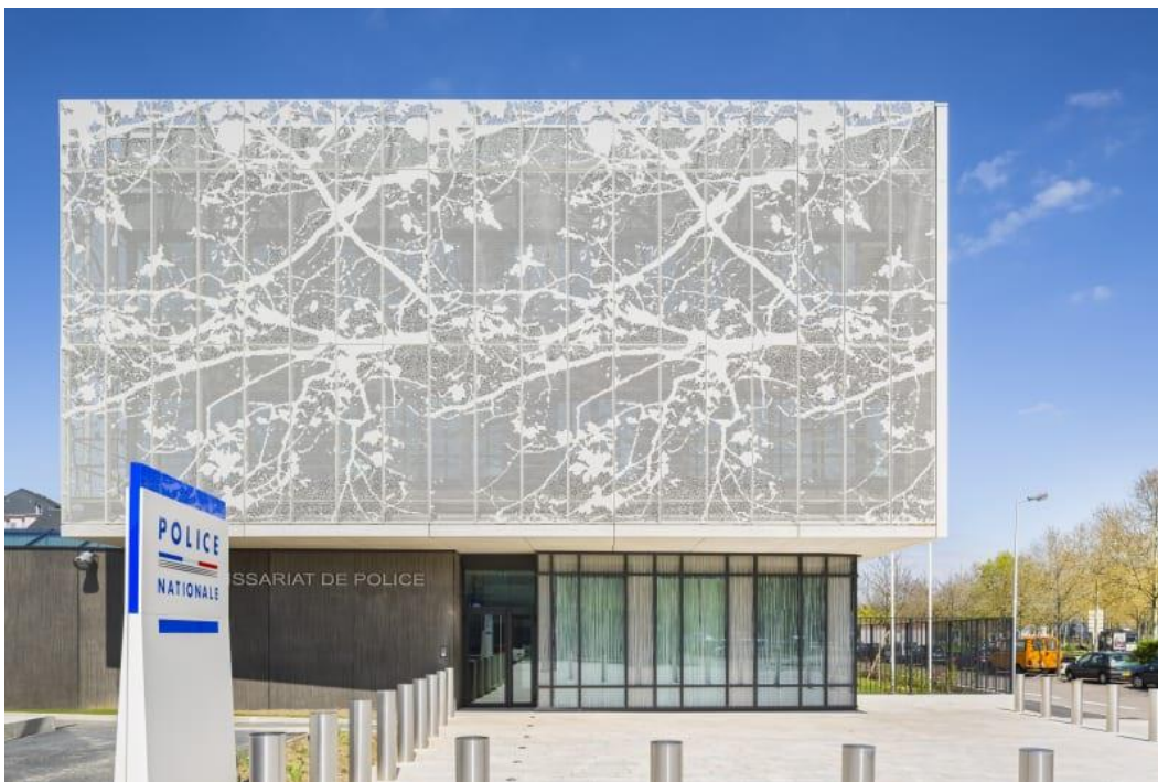
Rys. 6 Możliwość uzyskania różnorodnego efektu estetycznego za pomocą zastosowania perforacji CNC – Posterunek policji w Les Mureaux, Francja
