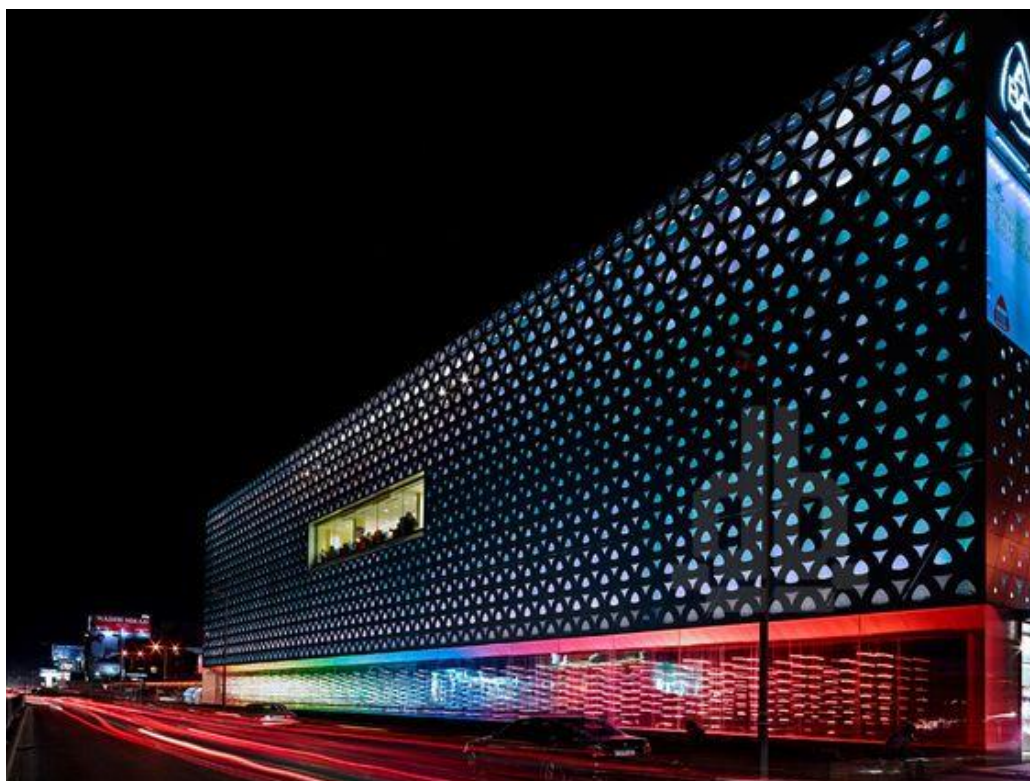
Rys. 7 Możliwość uzyskania różnorodnego efektu elewacji po zmroku z wykorzystaniem iluminacji LED – obiekt handlowy, ABC Dbayeh, Bejrut, Liban.
