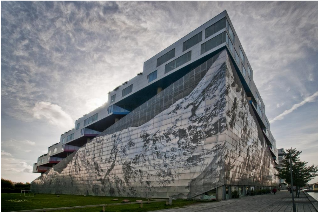
Rys. 5 Elewacja zespołu mieszkaniowo-parkingowego w Kopenhadze ze zróżnicowaniem perforacji w celu imitacji nadruku, Bjarke Ingles (BIG)
