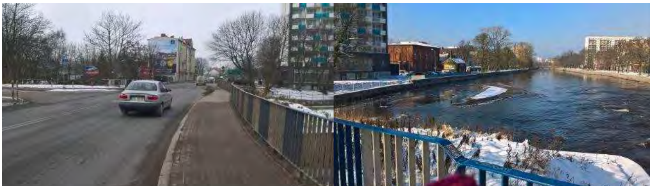
Zdjęcie 1 Most na Parsęcie na drodze wojewódzkiej nr 102, Źródło: UM Kołobrzeg
