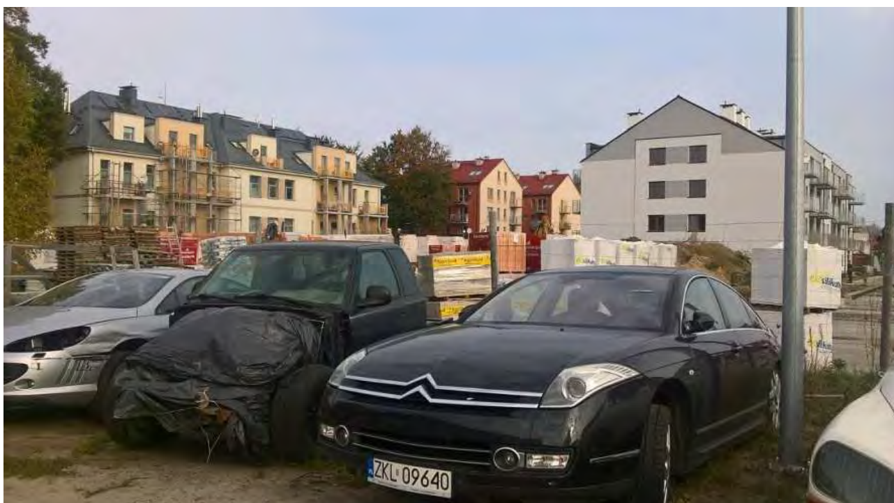
Zdjęcie 43 Nowe osiedla mieszkaniowe przy ul. Artyleryjskiej. Źródło: UM Kołobrzeg
