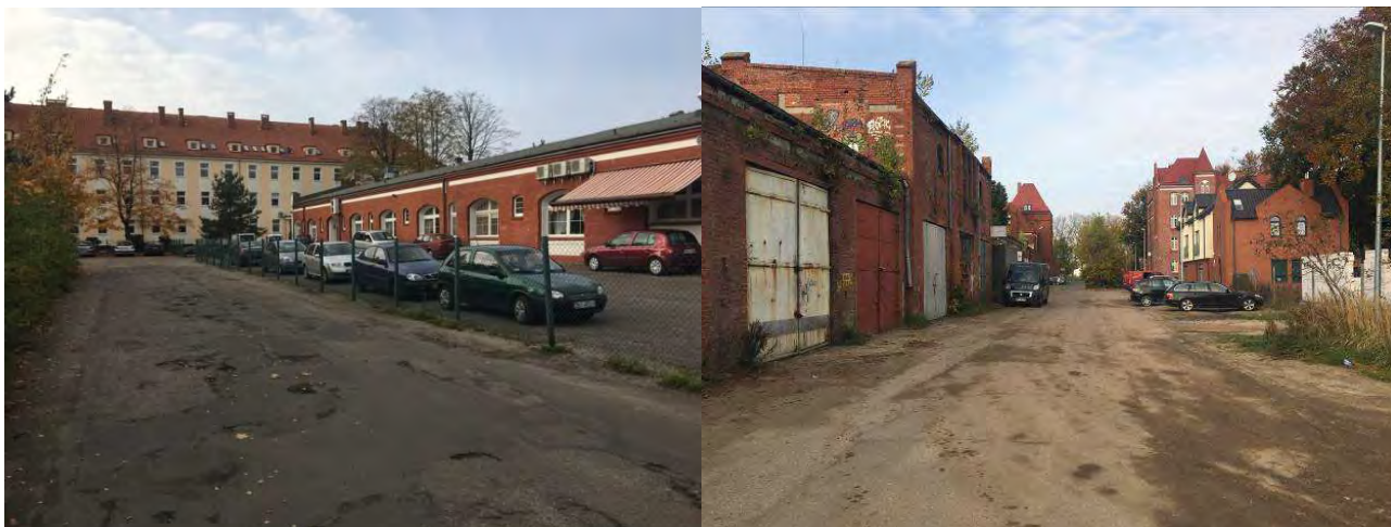
Zdjęcie 36 Drogi na terenie powojkowym. Źródło: UM Kołobrzeg
