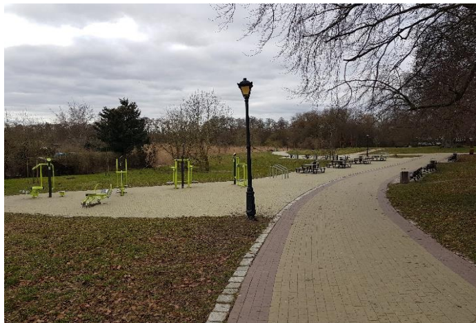
Park po przebudowie (własne)
