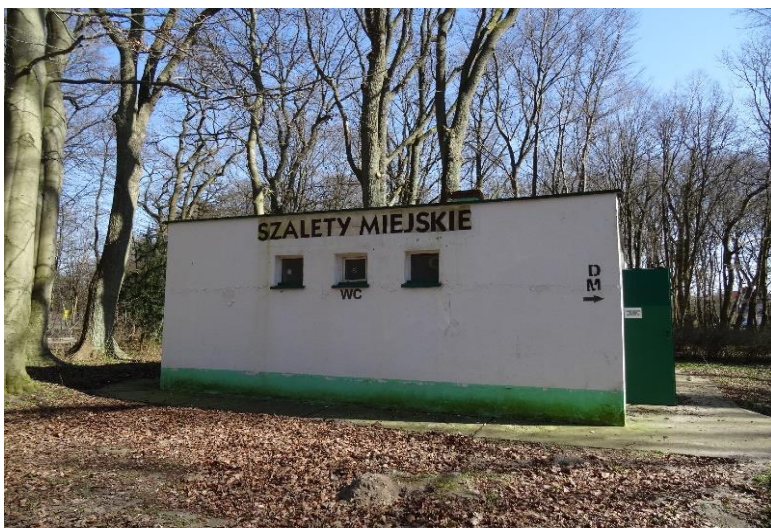
Toaleta przed przebudową (własne)
