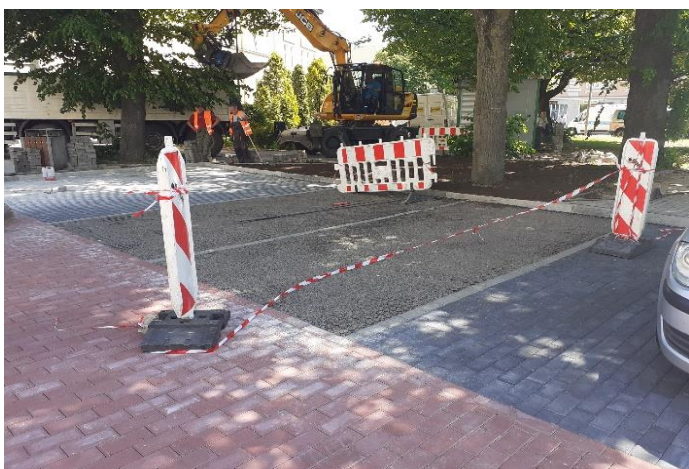
prace przy rozbudowie parkingu (własne)
