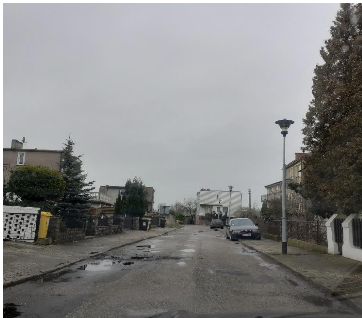
ul. Słoneczna przed przebudową (własne)
