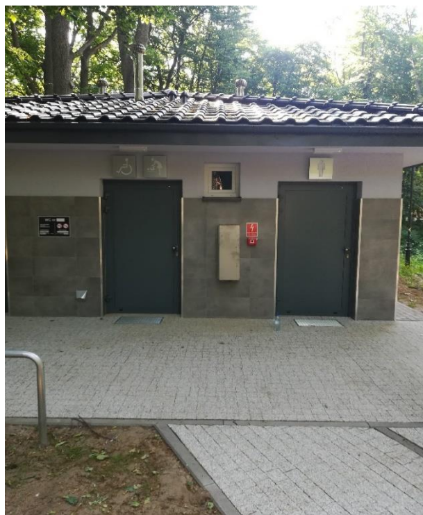
Toaleta po przebudowie (własne)
