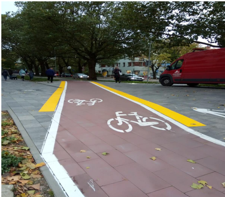
Zdjęcie: Oznakowanie rozdzielenia ścieżki rowerowej od ciągu pieszego Źródło: Urząd Miasta Kołobrzeg
