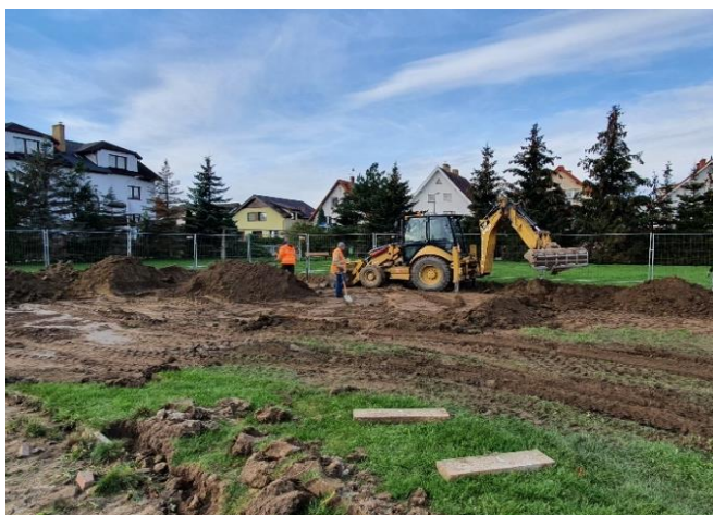
teren e trakcie budowy boiska (własne)
