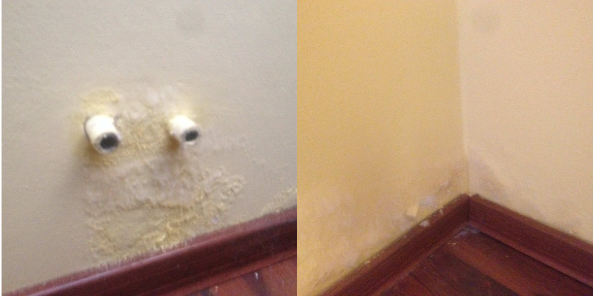
stan techniczny budynku wewnątrz
