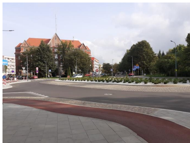
ul. 18 Marca po przebudowie (własne)
