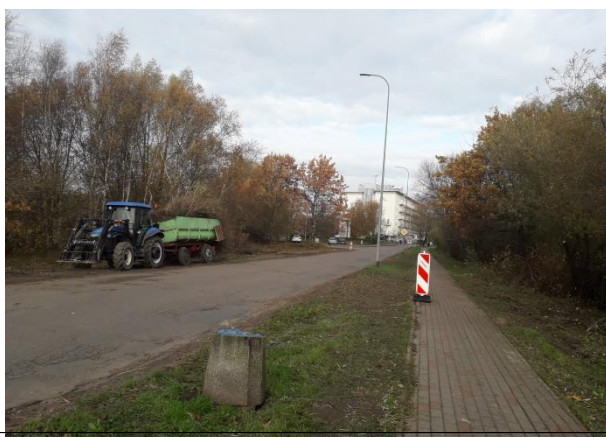
Id: 670A3C62-E0A4-4375-84BB-4A5FD2CF50D2. Przyjęty ul. Wschodnia przed przebudową (własne)
