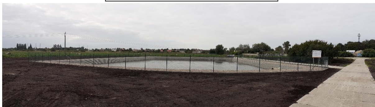
nowo wybudowany zbiornik (własne)
