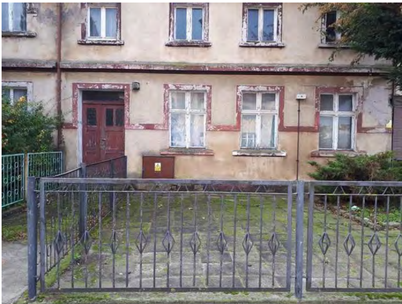
Zdjęcie 32 Budynek przy ul. Jedności Narodowej 60. Źródło: UM Kołobrzeg
