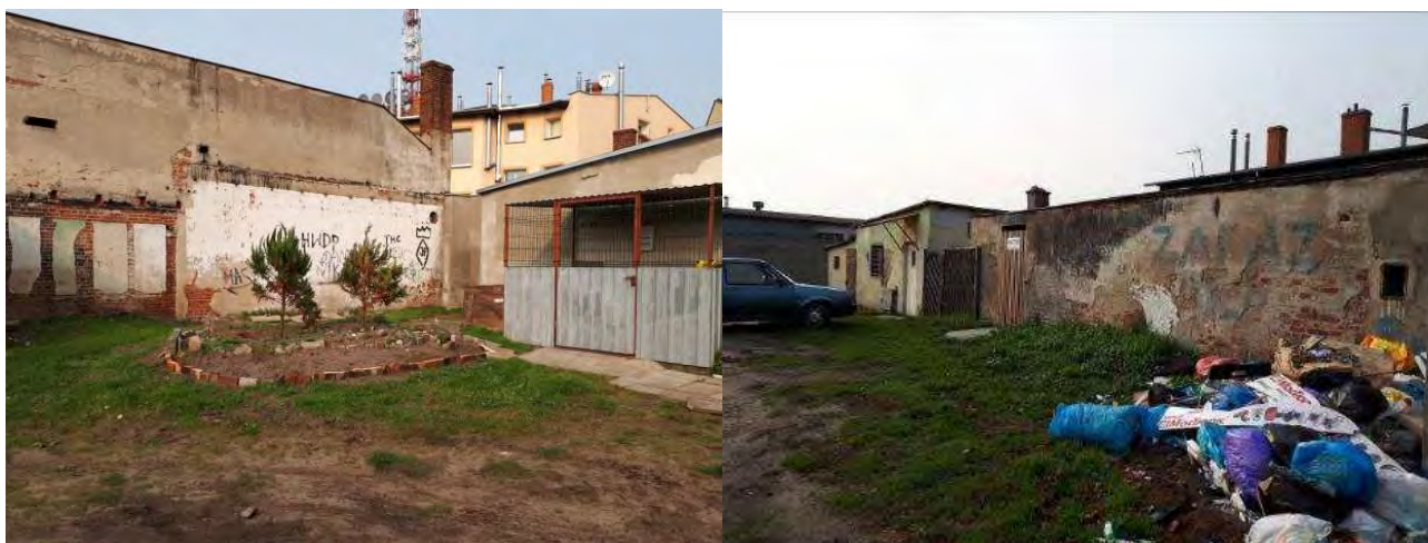
Zdjęcie 31 Podwórka przy ul. Jedności Narodowej. Źródło: UM Kołobrzeg
