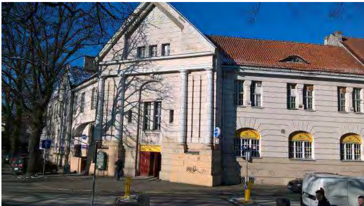
Zdjęcie 16 Dawna Elektrownia Miejska, Źródło: UM Kołobrzeg
