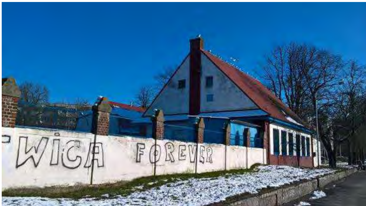
Zdjęcie 14 Przepompownia ścieków. Źródło: UM Kołobrzeg
