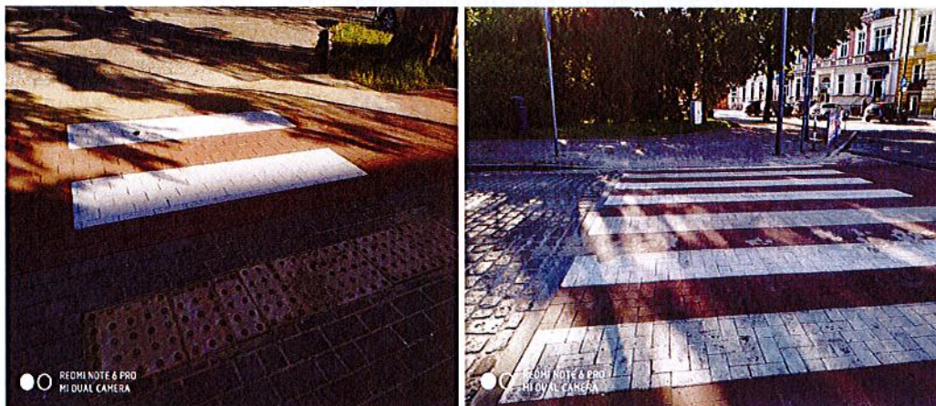
ul. Sybiraków – obniżenie krawężnika, płytki sensoryczne
